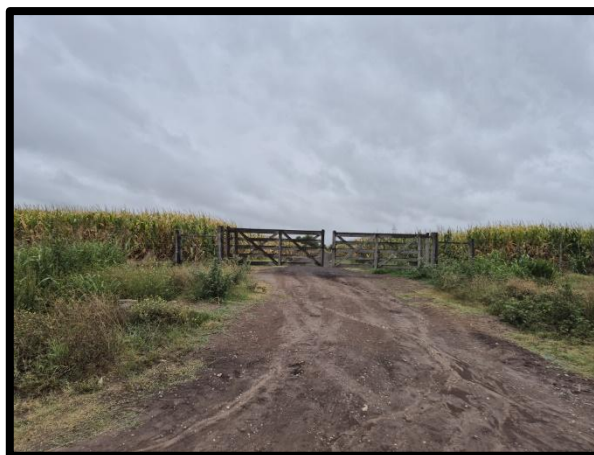
Figura 43 – Presencia de algunos portones de ingreso a campos privados sobre la RPN43.
