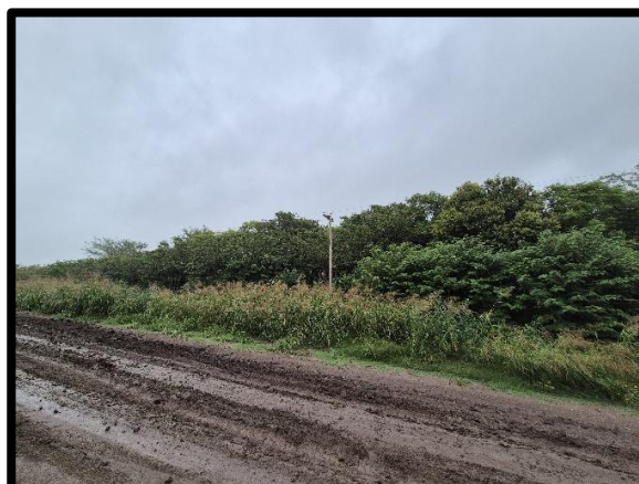
Figura 45 – Presencia de tendido eléctrico paralelo a la RPNº43, el cual cruza el arroyo del Sauce.
