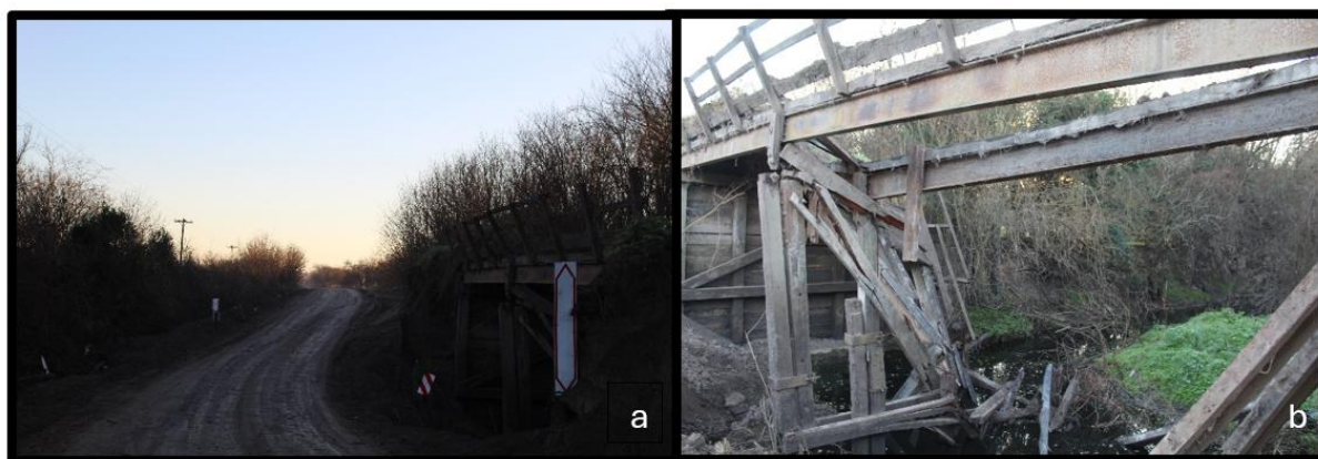
Figura 4 – Zona del proyecto: a) desvío provisorio. b) Antiguo puente colapsado. Fuente: Dirección Provincial de Vialidad – Entre Ríos (2024)
